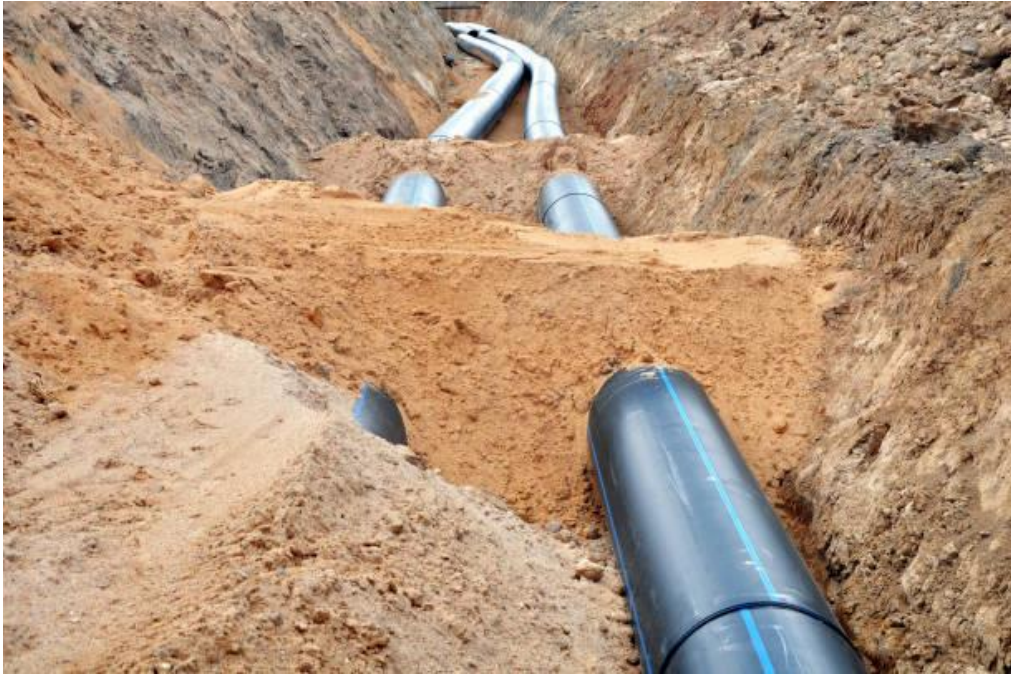
Excavation en tranchée
